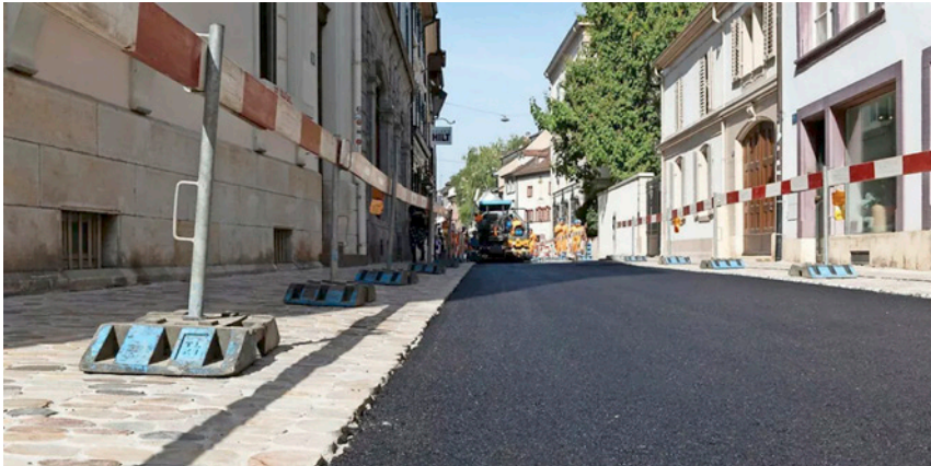
Abb. 03: Asphalt mit Zusatz von Pflanzenkohle in der St.-Alban-Vorstadt in Basel (Schweiz) [Foto: Baunetzwerk.biz]
