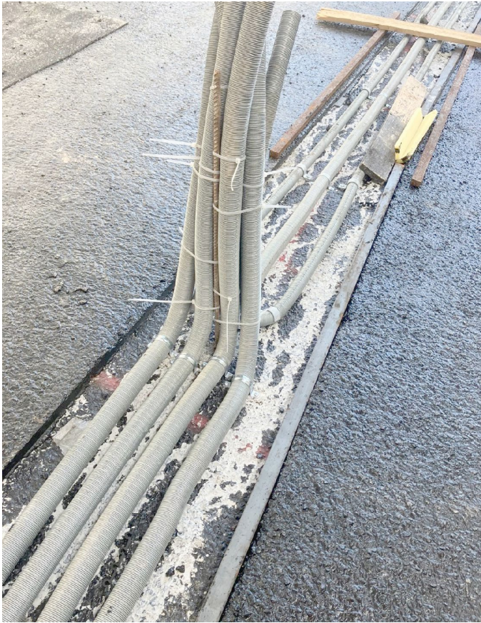
Abb. 03: Mit Metallschienen abgetrennter und gesicherter Sanierungsbereich
