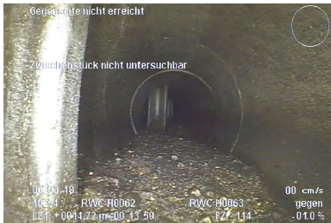
Abb. 03: Blick auf weitere eingerammte Schutzplankenpfosten
