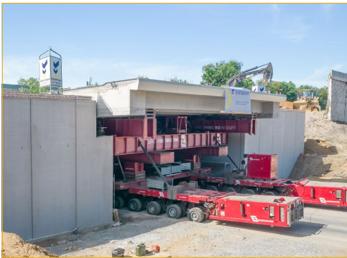
Abb. 03: Vershub eines halbseitigen Überbaus (1. Bauabschnitt) mittels SPMT-Fahrzeugen, Münsterstraße [Foto: Echthoff GmbH & Co. KG]
