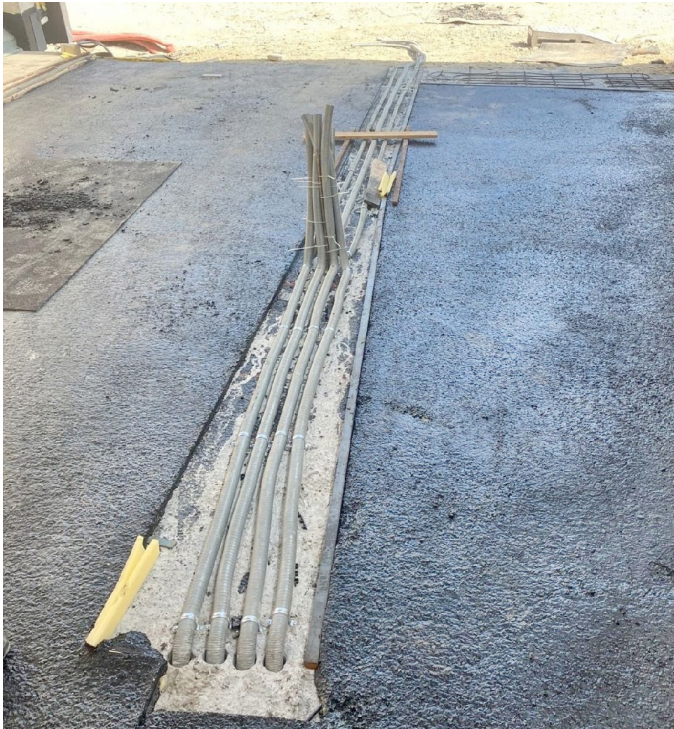
Abb. 01: Blick auf die Zu- und die Ausfahrtsrampe mit den mittig zwischen den Fahrbahnen verlegten Leerrohren
