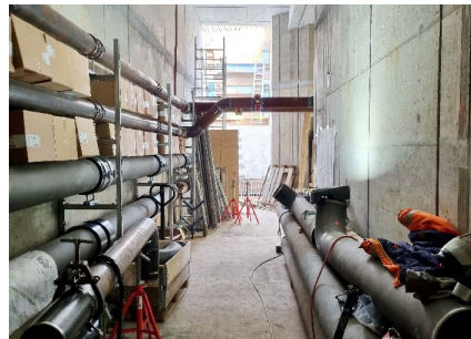
Abb. 03: Innerstädtisches Bauen, grabenlose Ausrüstung über Montageöffnungen [Foto: © GIBA mbH]
