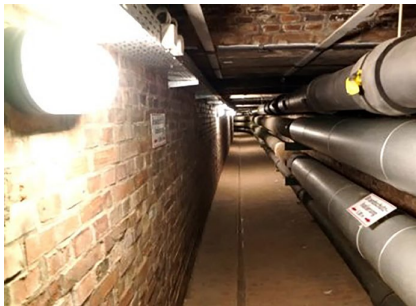
Abb. 02: Leitungskanal in der Dresdner Altstadt [Foto: © GIBA mbH]
