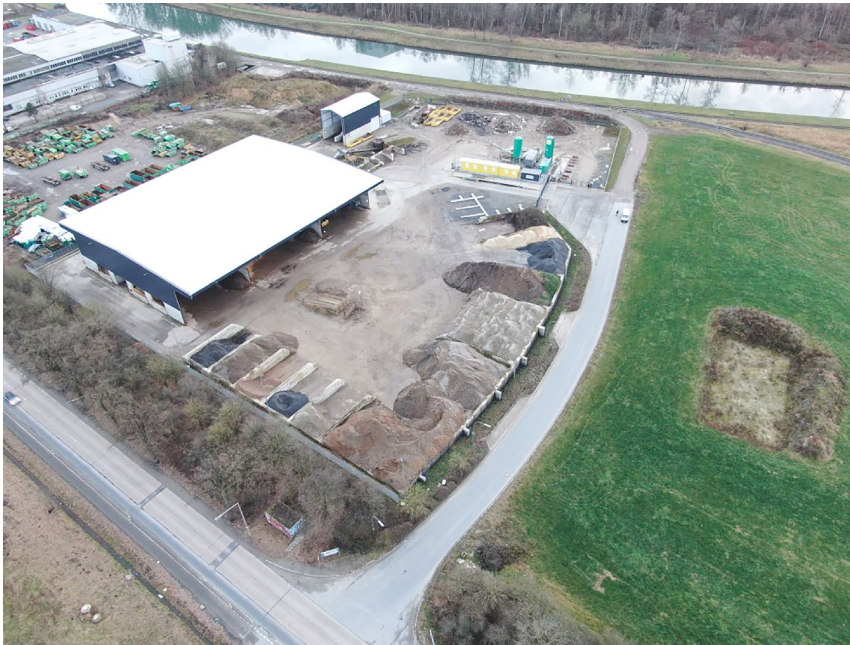
Abb. 01: Aufbereitungsplatz für Bodenmanagement, Mischanlage für Compound, Zement und Steuerungstechnik [Foto: Clausing GmbH Tiefbauunternehmen]
