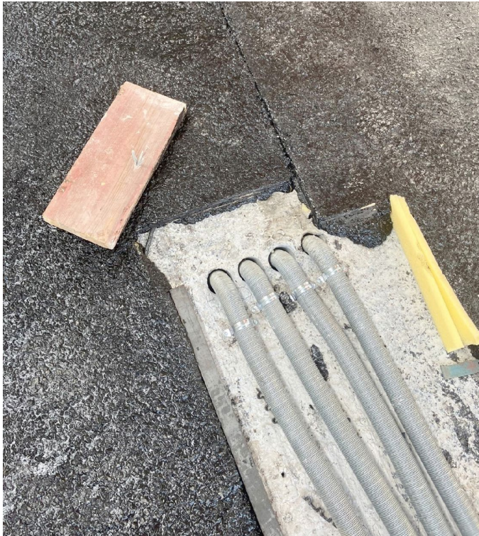
Abb. 04: Blick auf die noch zu sanierende erste Abdichtungsebene und die umgebende, bereits ausgeführte Schutzschicht aus Gussasphalt
