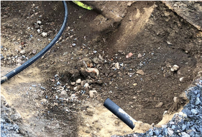
Abb. 03: Für die Reparatur vorbereitetes Erdkabel
