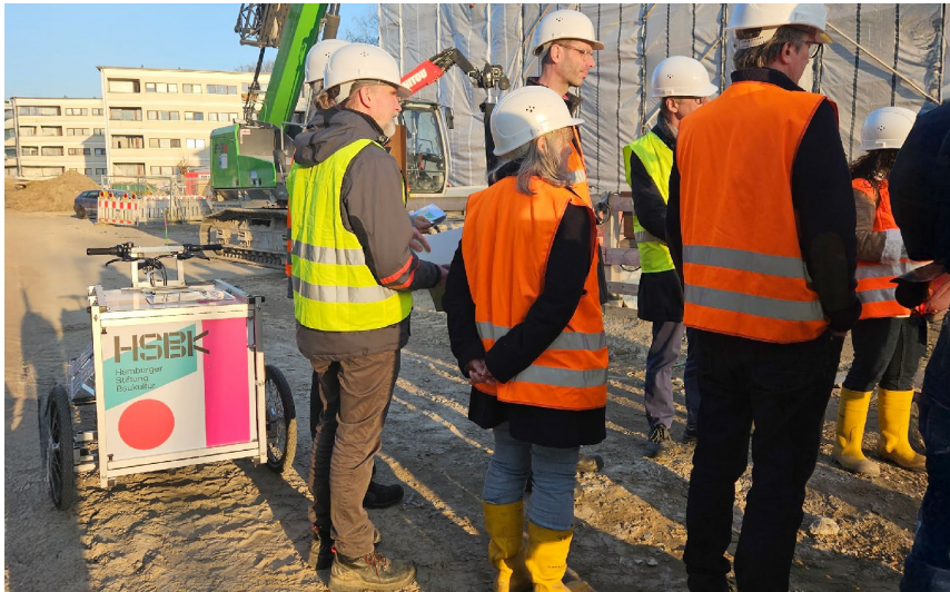
Abb. 03: In unterschiedlichen Formaten, hier bei der HSBK-Tour bei der Hamburger Hochbahn, werden Informationen weitergegeben und Exkursionen zu Baustellen angeboten. [Foto: Tina Unruh]
