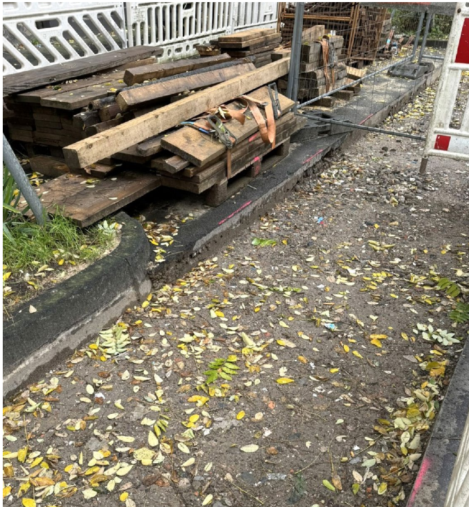
Abb. 01: Blick auf den Gehweg; die Pflastersteine sind bereits entfernt
