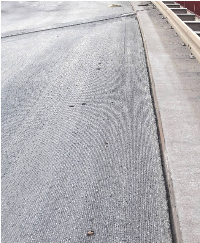
Abb. 01: Blick auf den teilweise abgefrästen Asphaltbelag
