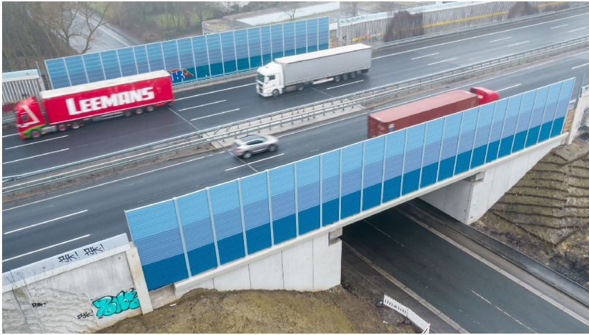
Abb. 05: Bauwerk Münsterstraße nach Fertigstellung [Foto: Echthoff GmbH & Co. KG]
