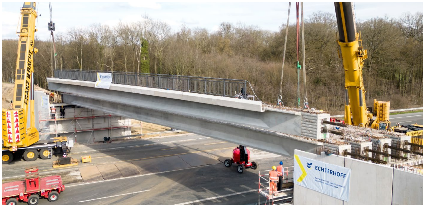
Abb. 10: Einheben eines Randträgers mit bereits vormontierter Carbonkappe und Geländer, Bauwerk Amelsbürener Straße [Foto: Echterhoff GmbH & Co. KG]
