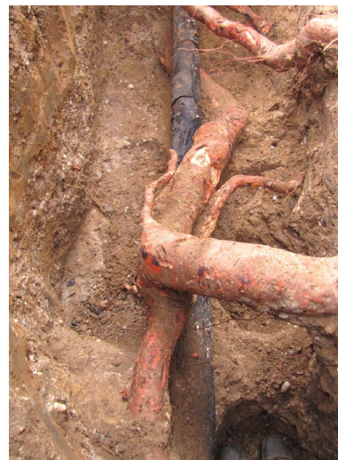
Abb. 11: Wurzel-Leitungs-Interaktion [Foto: ArborPlan GmbH & Co. KG]
