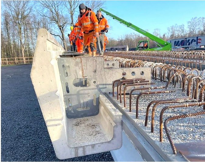
Abb. 09: Hybride Kappe mit Schalungselement aus Carbonbeton (System der Unternehmensgruppe Echterhoff), Bauwerk Amelsbürener Straße [Foto: Echterhoff GmbH & Co. KG]
